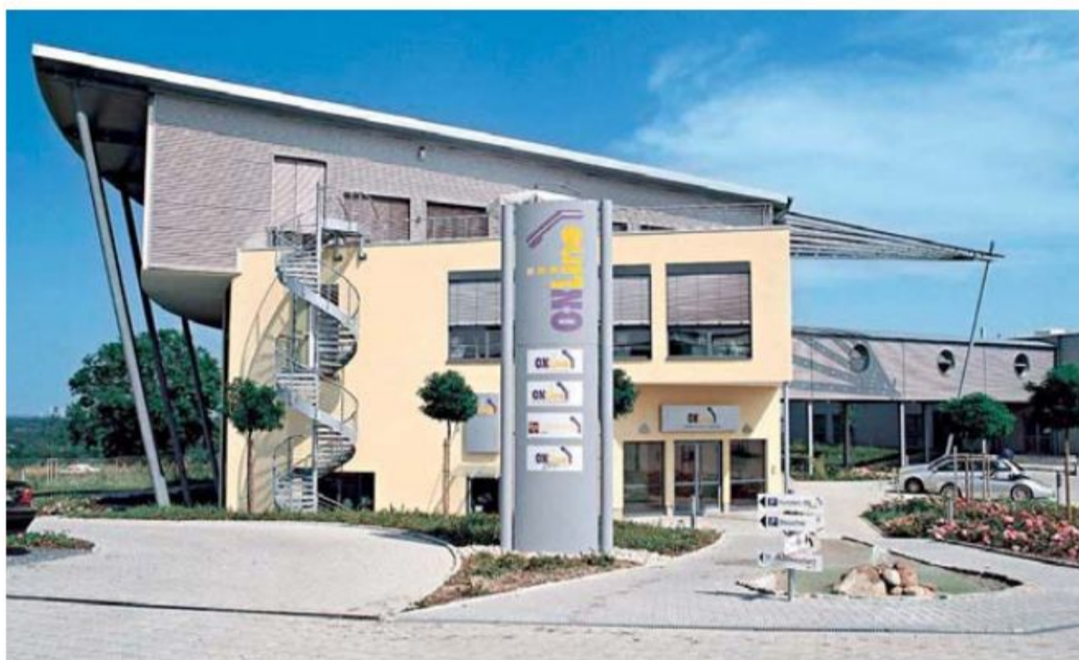
Firmenzentrale der ONLine Distribution GmbH in Unna
